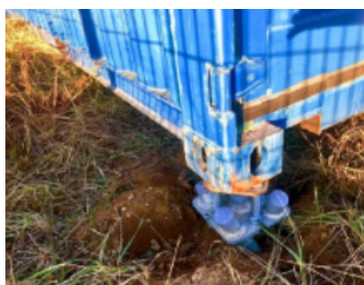
Rysunek 6 Przykład wykorzystania systemu EF oraz przedstawienie modułu pozycjonującego w użyciu
