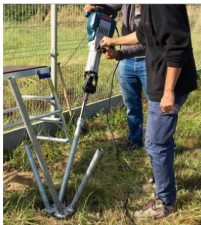
Rysunek 15 Wbijanie pali młotem elektro-udarowym
