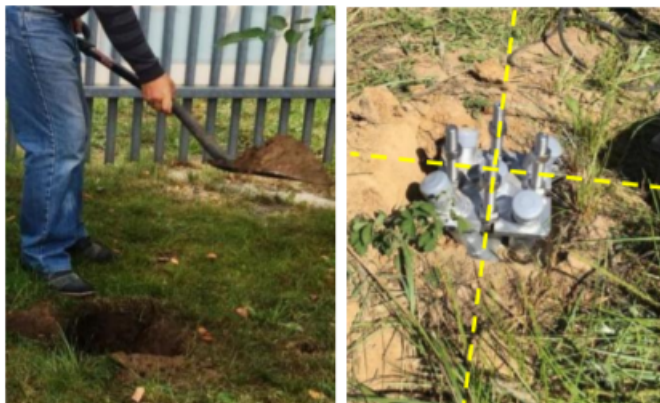
Rysunek 13 Wykopy w gruncie i ułożenie modułu pozycjonującego EasyFootings Źródło: https://easyfooting.com/
