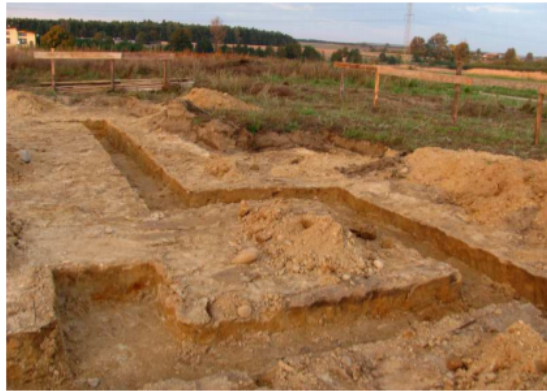
Rysunek 2 Wykopy przygotowane pod łąwy fundamentowe
