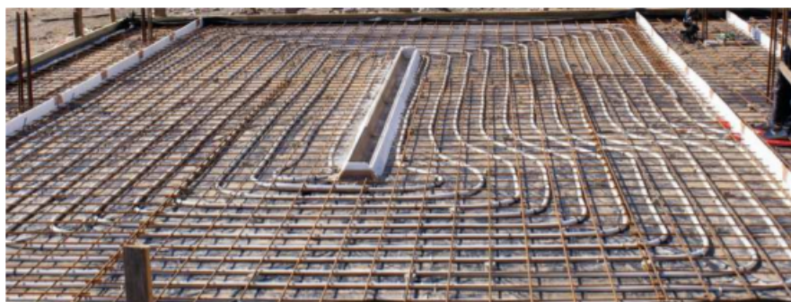
Rysunek 4 Ułożenie zbrojenie płyty fundamentowej wraz z instalacją ogrzewania podłogowego Źródło: Major I., Technologia budowy domów szkieletowych - ekologiczna forma jednorodzinne budownictwa mieszkaniowego, [w:] Jakościowe i ekologiczne aspekty w technologiach budowlanych, pod red. M. Ulewicz, J. Selejda, Sekcja Wydawnictw WZPCz, Częstochowa 2013
