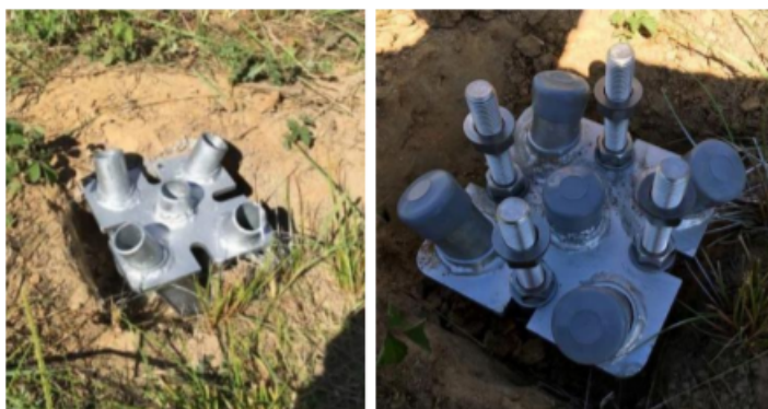
Rysunek 16 Montaż zatyczek ochronnych
